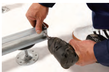
5 端部床板固定金物取付け
