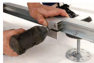
6 幕板固定金物取付け
