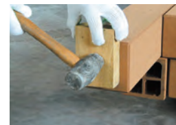
キャップ打込み
